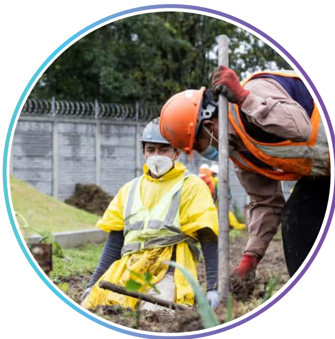
Subestación Chiantla, Chiantla Huehuetenango
